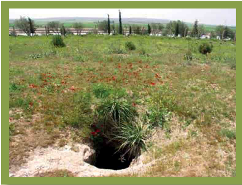
إحدى فتحات التنظيف ولا يزال هناك العشرات منها لتنظيف مجرى القناة.
