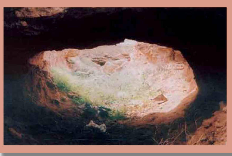
قناة العاشق محفورة في الصخر وهي قرب ناحية تل الدرة والإضاءة الخلفية تدخل من فتحة التنظيف العلوية.
