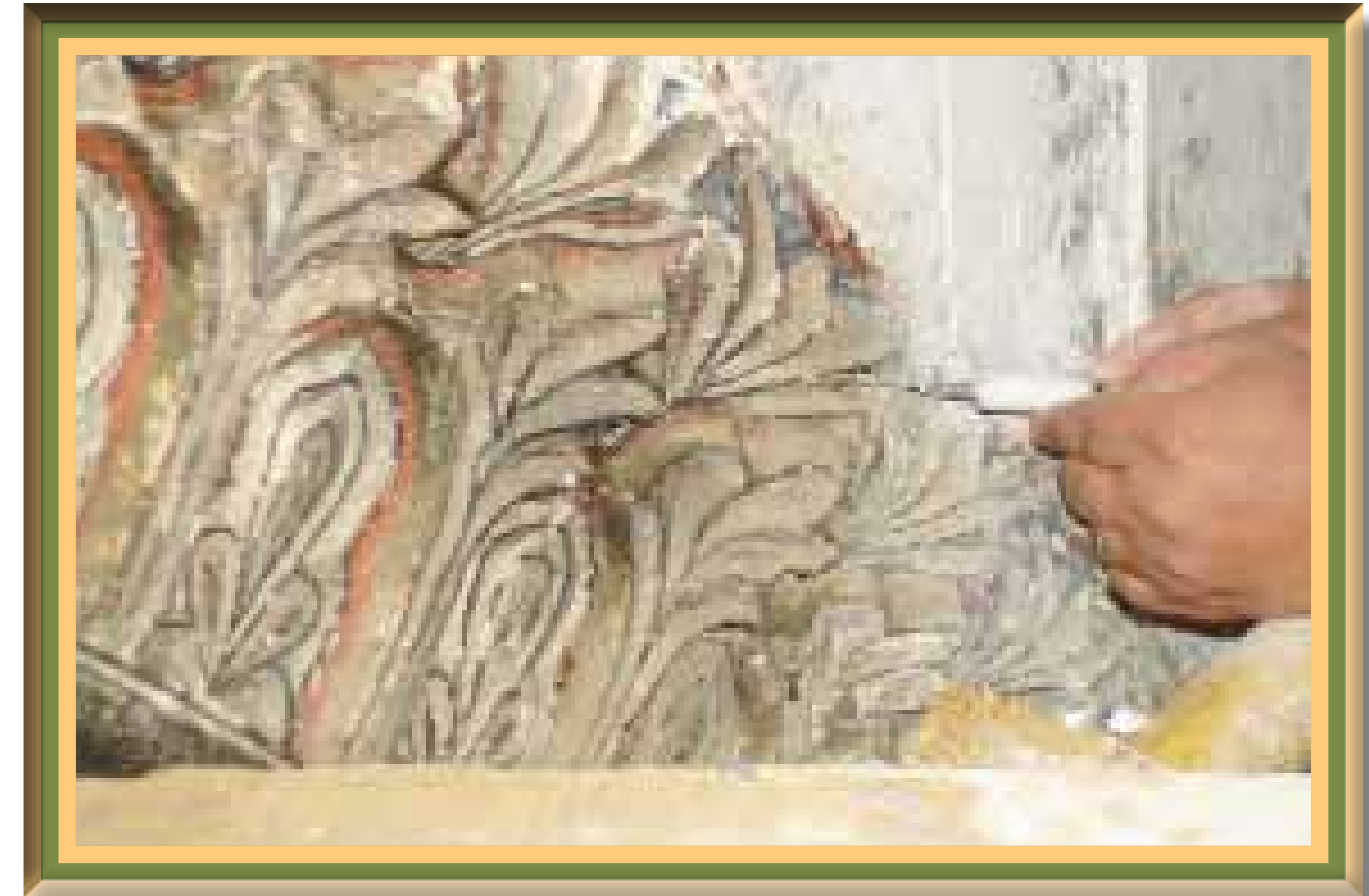
عند الانتهاء من تنظيف الغبار من على الجصين تبقى هناك أنلام لا يمكن رتقها إلا بمادة السلكون وهذا مايفعله هذا المرمم.
