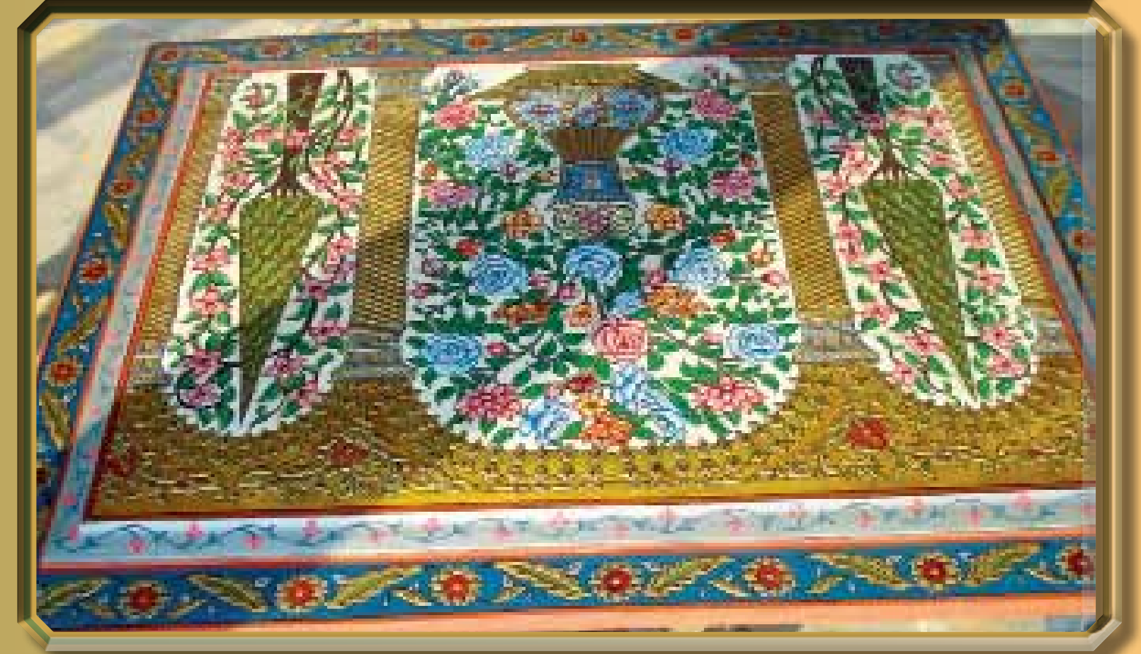
تم صناعة هذا اللوح العجمي من الجبصين والليف ليتقوى ويبدأون بتلوينه بالأصباغ الزاهية وهذا العمل يكون على الأرض. بعدها يرفع ويثبت في مكانه.
