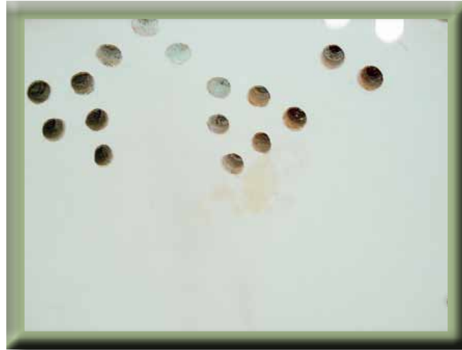
إحدى القاعات التي رمت ويظهر هنا من الداخل والخارج الفتحات الزجاجية التي تسمح بمرور الإضاءة الطبيعية.
