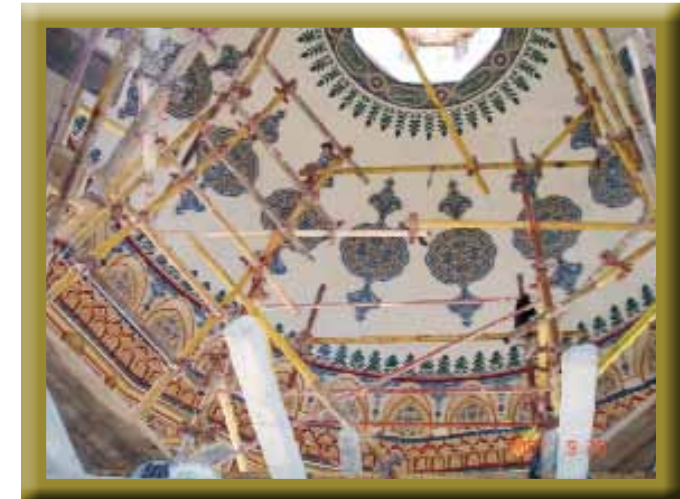
عند الانتهاء من تنظيف الغبار من على الجصين تبقى هناك أنلام لا يمكن رتقها إلا بمادة السلكون وهذا مايفعله هذا المرمم.
