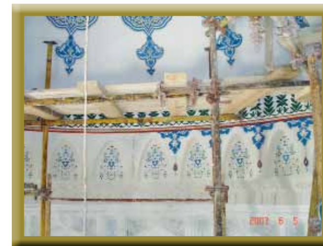
عند الانتهاء من تنظيف الغبار من على الجصين تبقى هناك أنلام لا يمكن رتقها إلا بمادة السلكون وهذا مايفعله هذا المرمم.
