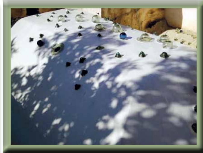
إحدى القاعات التي رمت ويظهر هنا من الداخل والخارج الفتحات الزجاجية التي تسمح بمرور الإضاءة الطبيعية.
