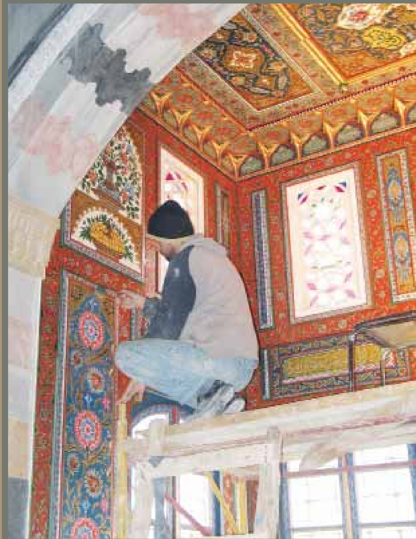
ترميم وتثبيت الألوان بماء الذهب وهذا يتطلب شهوراً من العمل المتواصل.
